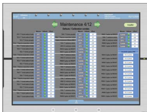
Etalonnage des sondes
