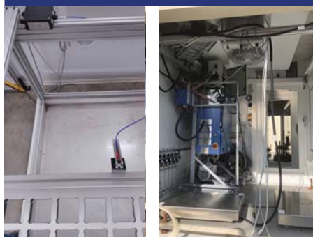
Contrôle CO2 Contrôle Bilan carbone Cellule haute étanchéité
