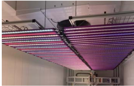
2 types d'éclairage multispectral différents (UV blanc/bleu/rouge/rouge sombre IR)
