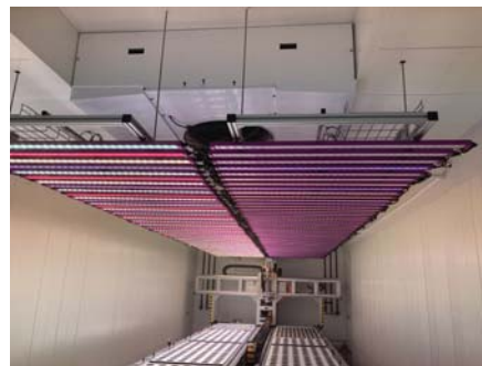
LED multispectre variable par zone haute intensité
