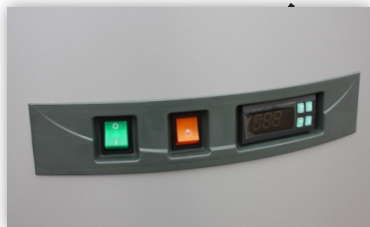
Panneau de commande du groupe froid et interrupteur pour l'éclairage (220 V)
